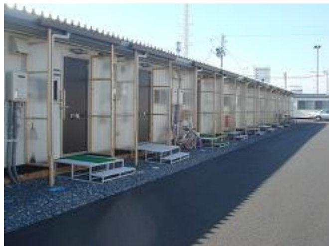
大橋地区の仮設住宅
