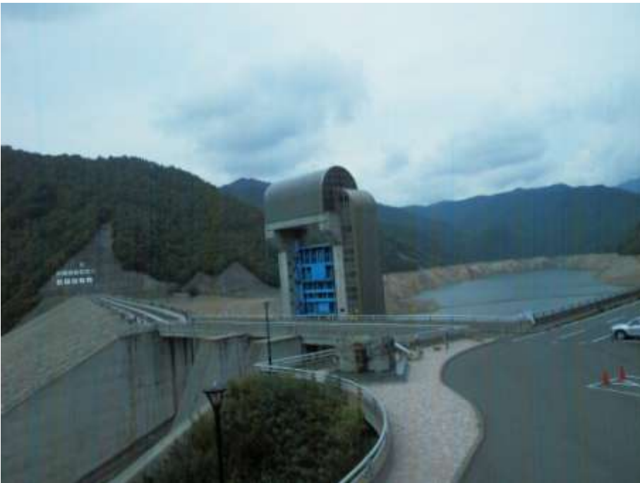
上毛カルタ：㊦そう（理想）の電化に 電源群馬 （群馬県利根郡みなかみ町 奈良俣ダムにて～利根川水系榑俣川～）
