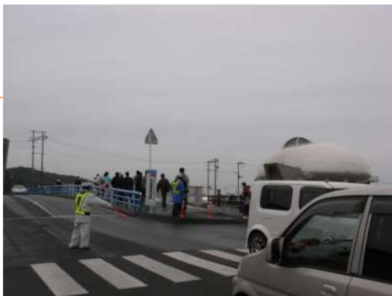
修復された、内海橋歩道。
