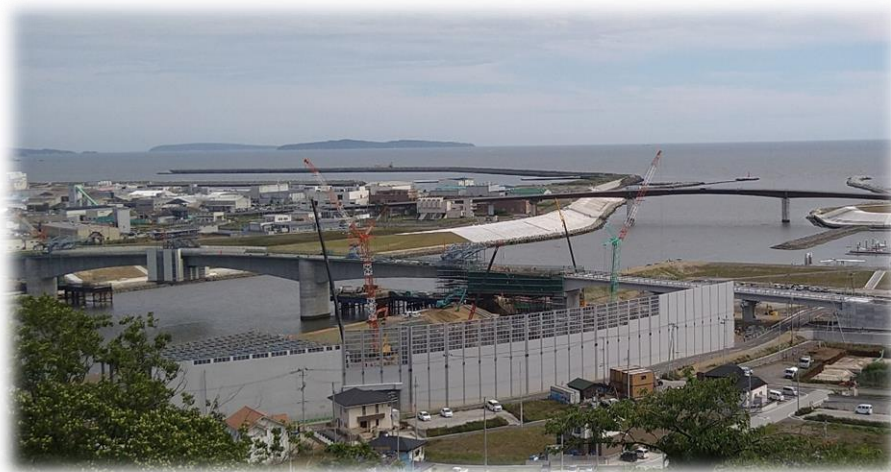
手前が、新しく建築中の「石巻かわみなと大橋」今年度中には完成予定
