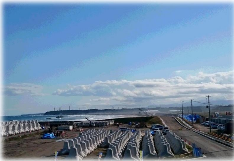
～請戸地区漁港からの福島第一原子力発電所～
