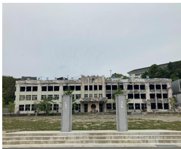
↑ 石巻市震災遺構門脇小学校
