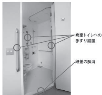
病室トイレへの手すり設置
